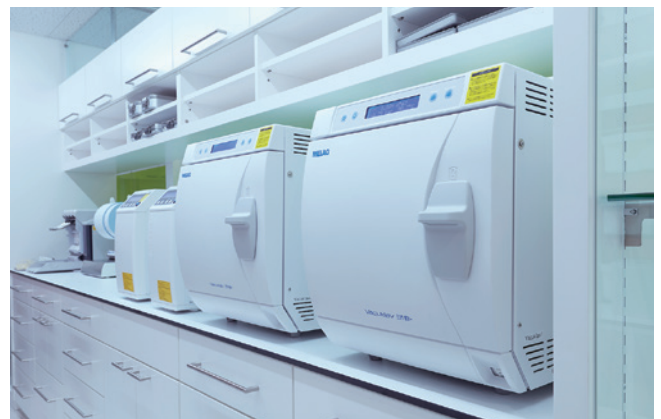
図11 クリティカルAとBにリスク分析されたインスルメントおよびハンドピースは、WDと4台のスチームステリライザーにて対応している。
